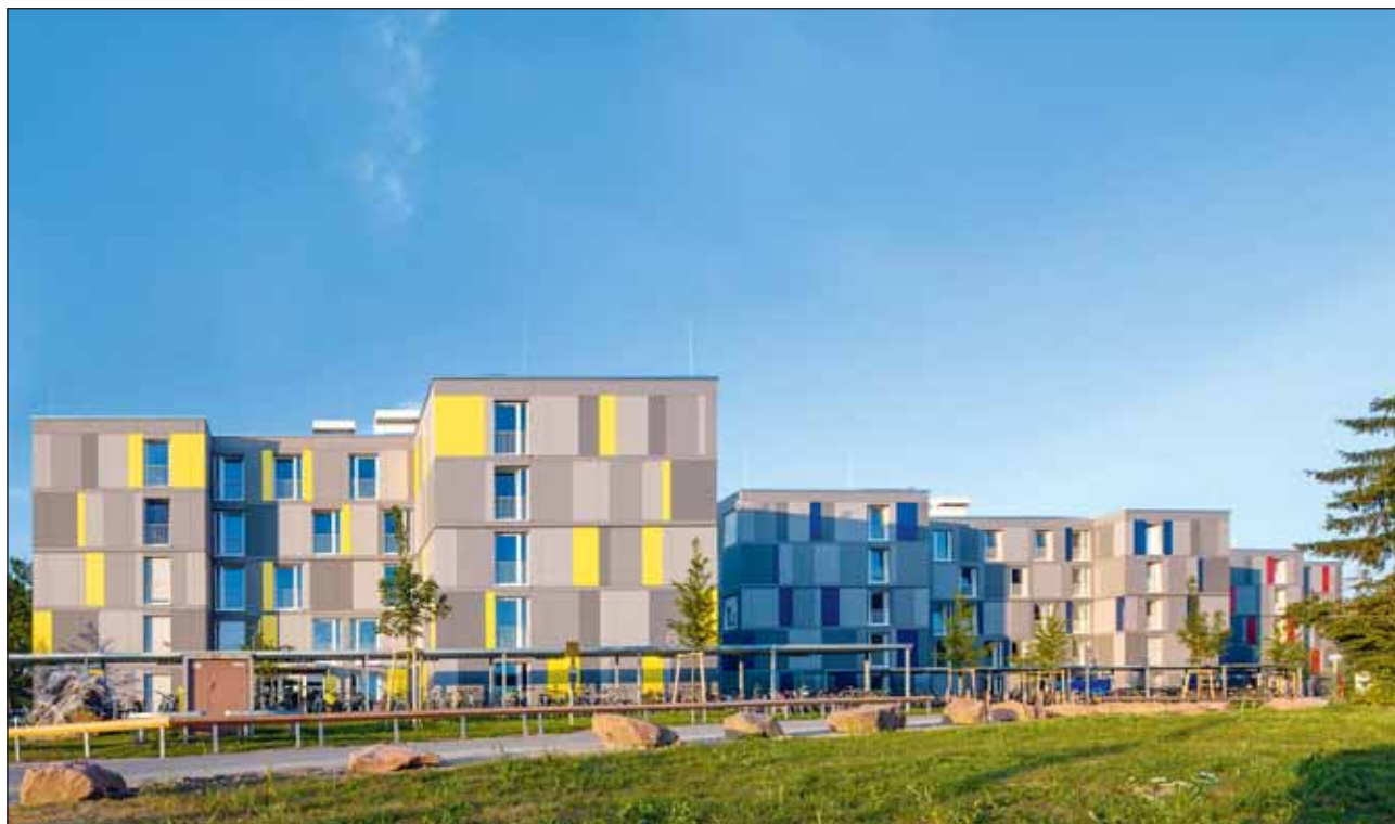
Trzy pięciopiętrowe budynki z mieszkaniami studenckimi w kampusie „Im Neuheimer Feld“ w Heidelbergu składają się z 265 modułów przestrzennych. Są one rozmieszczone w różnych układach i zapewniają miejsce dokładnie tylu studentom, ile jest modułów. Domy mają klasę budynków 4.
