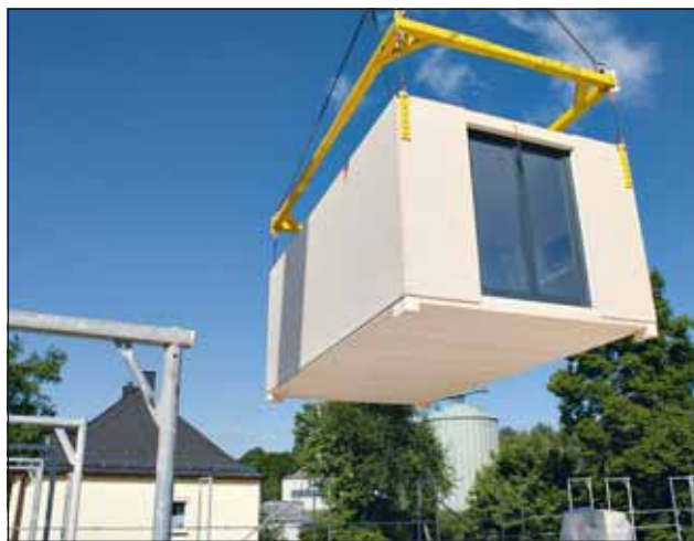
Podnoszenie komórki przestrzennej na budowie – z już wbudowanymi oknami. Profile podpierające w kształcie litery L pełnią funkcję złącza wtykowego w rogach brył. Zdjęcie: MW Modul Holz
