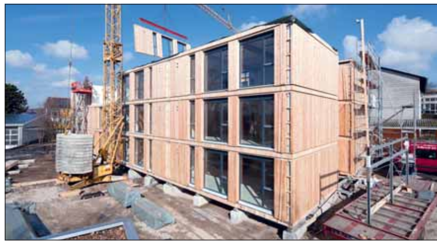
Modułowy system konstrukcji zespołowej „Mobi space“ z wykonanych wcześniej ścian i sufitów jest prosty w budowie i podczas usuwania budowli. Moduły przestrzenne można w dowolny sposób dodawać i układać na sobie do wysokości aż trzech kondygnacji. Zdjęcie: Werkum-Architekten
