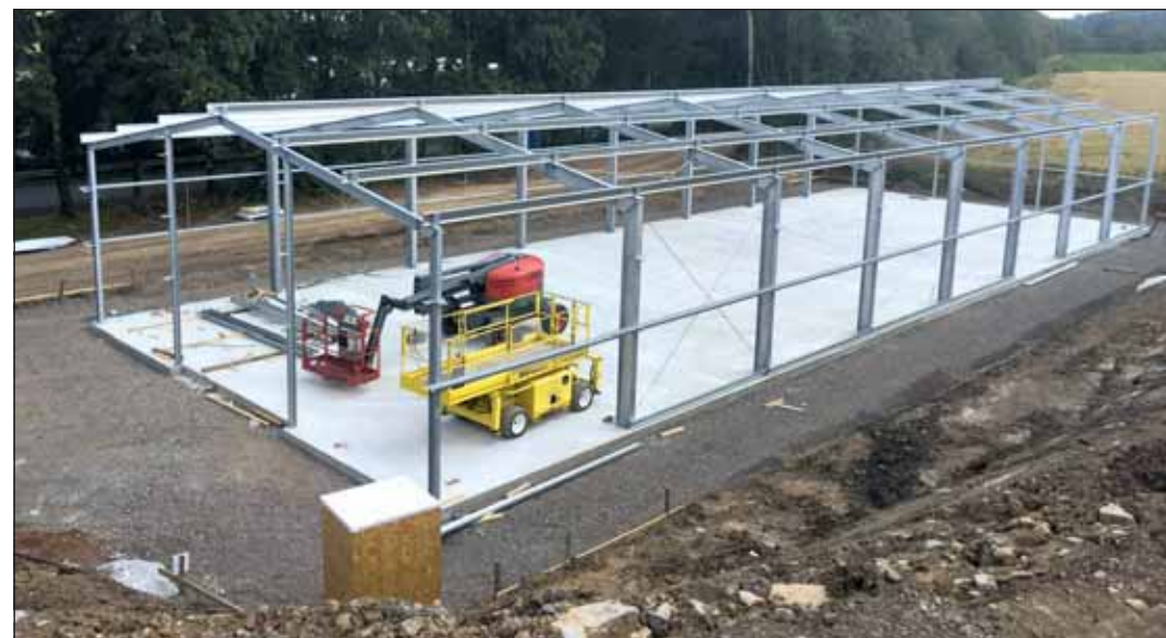
W dolnej części terenu zakładowego w Ober-Seemen postawiono w lipcu dodatkową halę magazynową do przechowywania surowców i magazynowania pośredniego gotowych zleceń.
