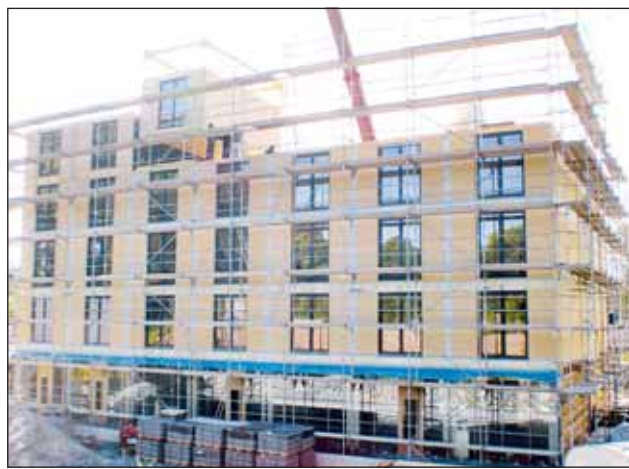
Odpowiada to powszechnie stosowanej w budownictwie modułowym koncepcji, polegającej na układaniu na sobie i łączeniu w rzędach elementów będących modułami z dwiema stronami. Zdjęcie: MW Modul Holz
