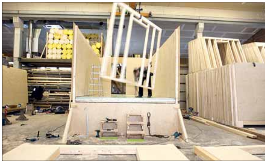
Prefabrykacja modułów przestrzennych o wielkości 3,60 m x 7,00 m w oparciu o drewniane ramy. Zdjęcie: MW Modul Holz
