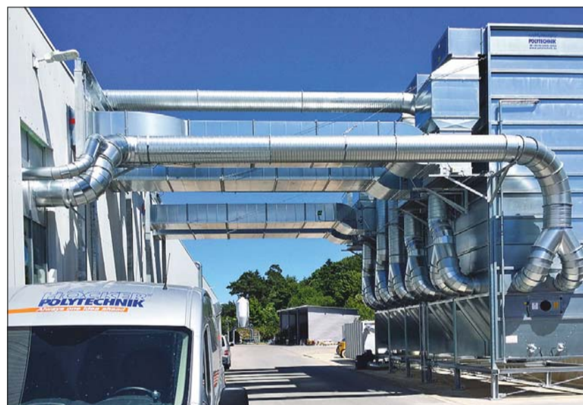
Również firma Homag AG, jeden z wiodących producentów maszyn i urządzeń do przemysłu drzewnego wykorzystuje instalacje „Multi Star“ – na zdjęciu instalacja o powierzchni filtracyjnej 1243 m 2 z oczyszczaniem wibracyjnym i wyprowadzeniem materiału przy pomocy przenośnika łańcuchowego.
