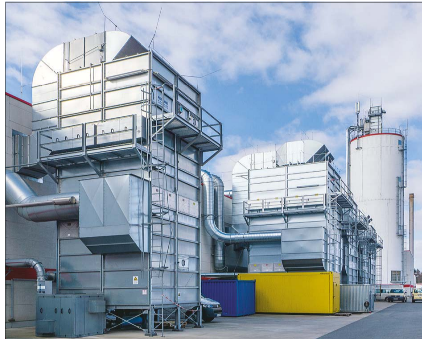
Instalacja odpylania w firmie Nobilia składa się z pięciu filtrów mieszalnikowych z oczyszczaniem strumieniowym i nasadowym filtrem silosowym.
