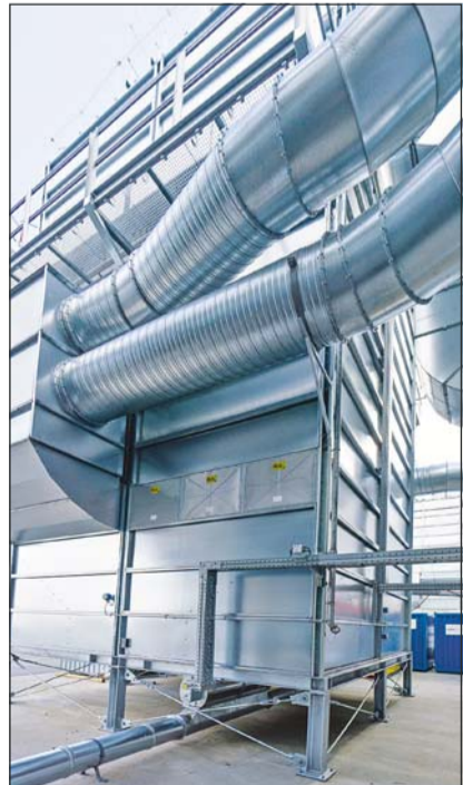
Transport odfiltrowanego materiału do silosa przy wykorzystaniu śruby celkowej i systemu transportu pneumatycznego
