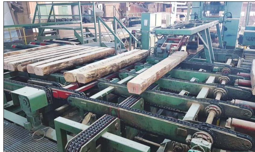
Trak rozpuszczania pryzmy z automatycznym centrowaniem, zakupiony w stanie używanym w 2008 r. i przekonstruowany na miejscu. Zdjęcie: Tartak Enders
