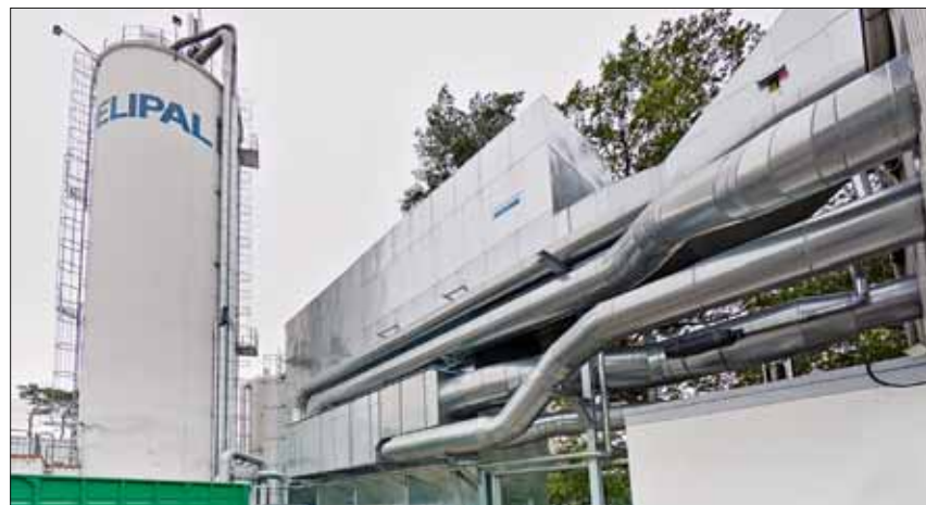
Filtr powietrza oczyszczającego „Multi Star” (po prawej) o poziomie hałasu 35 dB(A) jest ledwo słyszalny.
