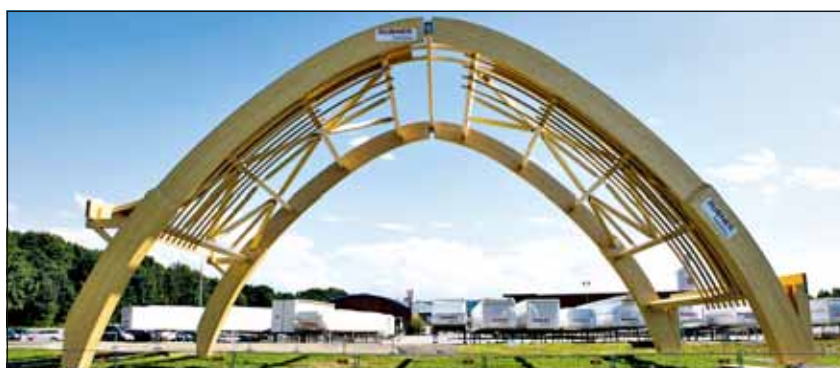
Montaż próbny kratownic BSH w zakładzie w Ober-Grafendorf, załadunek elementów drewnianych w porcie śródlądowym Krems, przeładunek elementów w Antwerpii.
