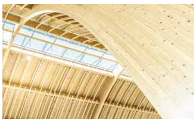
Widok na konstrukcję dachu z płyt BSH i OSB: opaska usztywniająca nie mogła być doprowadzona do podłogi.
