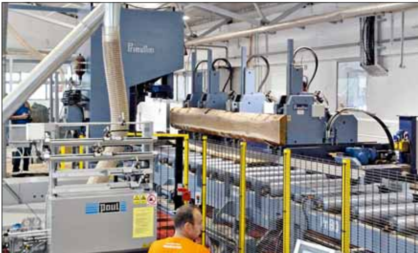
Linia obrzynania firmy Paul stanowi uzupełnienie pily taśmowej firmy Primultini. Tartak ma roczną wydajność cięcia na poziomie 25 000 kubików.
