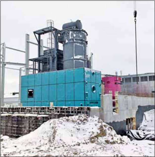
Montaż linii KWK w tartaku Olczyk
