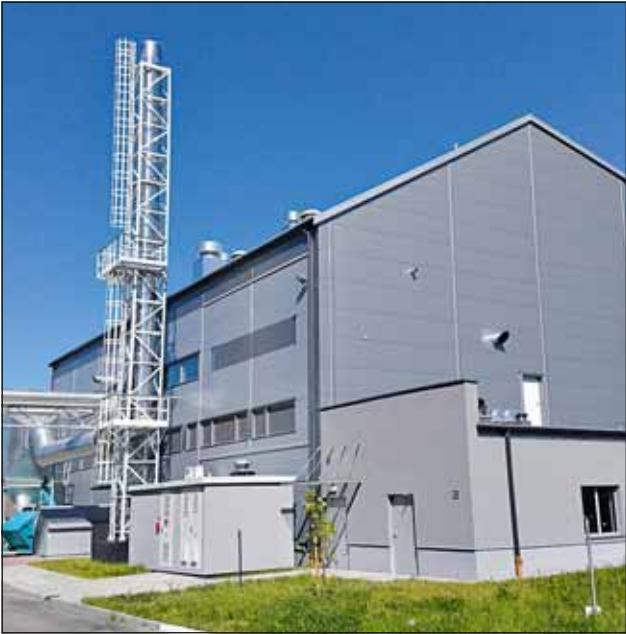
Wygląd centrali grzewczej w Łęborku z zewnątrz
