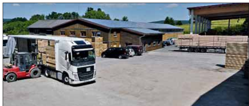
Plac załadunkowy i nowa hala załadunkowa (po prawej), pośrodku budynek biurowy, za nim strugarnia Zdjęcia: L.Pirson
