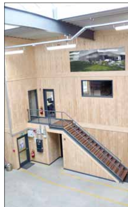
Do wykończenia wnętrza wykorzystano drewno lite, na zdjęciu widoczna jest przestrzeń z pomieszczeniami biurowymi i socjalnymi.
